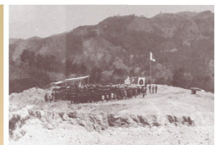
口和中学校 (造成中の敷地での入学式風景)
